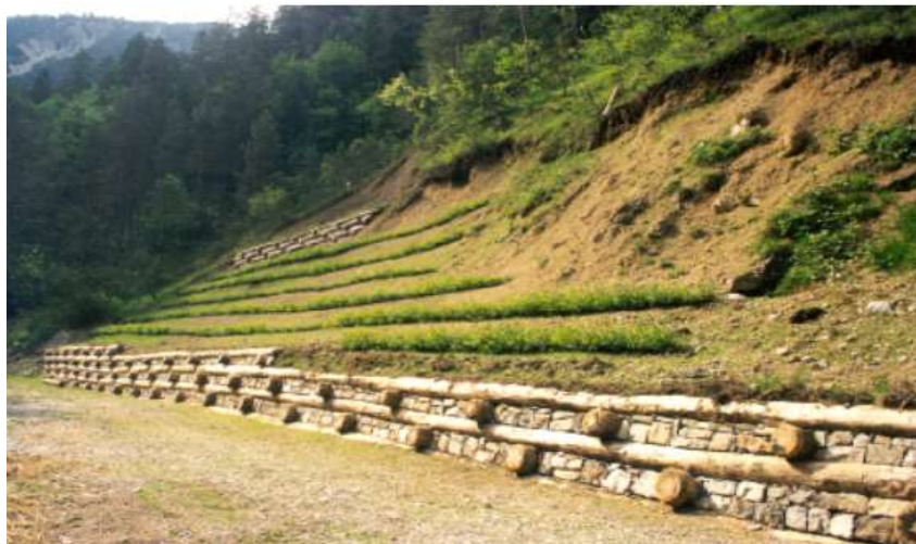
Slika 65: Kombinacija različnih inženirsko bioloških metod stabilizacije 110
