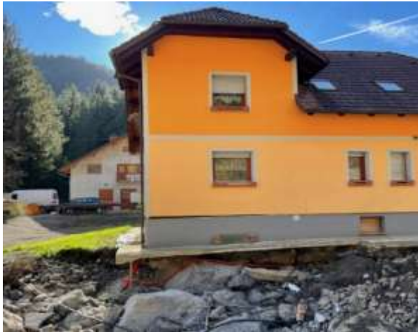
Slika 44: Primer gradnje v Strugah 82
