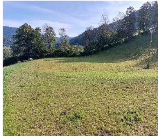
Slika 61: Zaledje plazu pod lokalno cesto (Jezernik) 100
