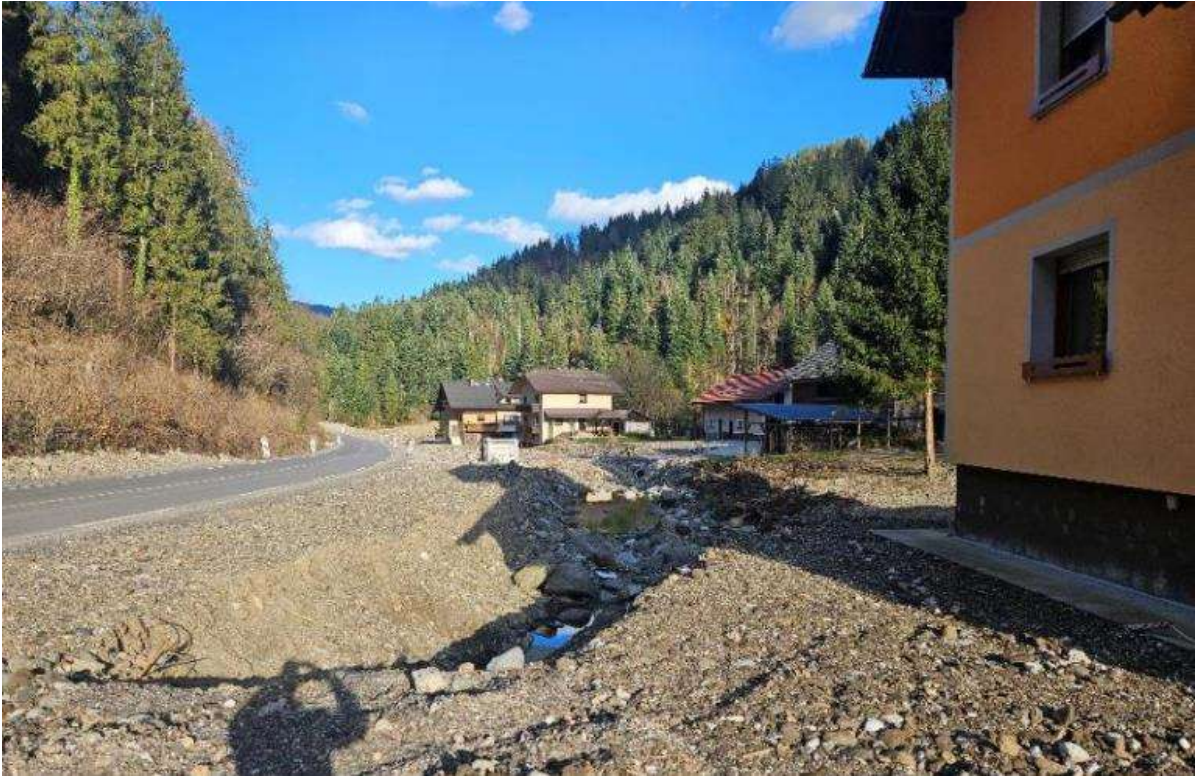
Slika 67: Sanacija v Strugah 112
