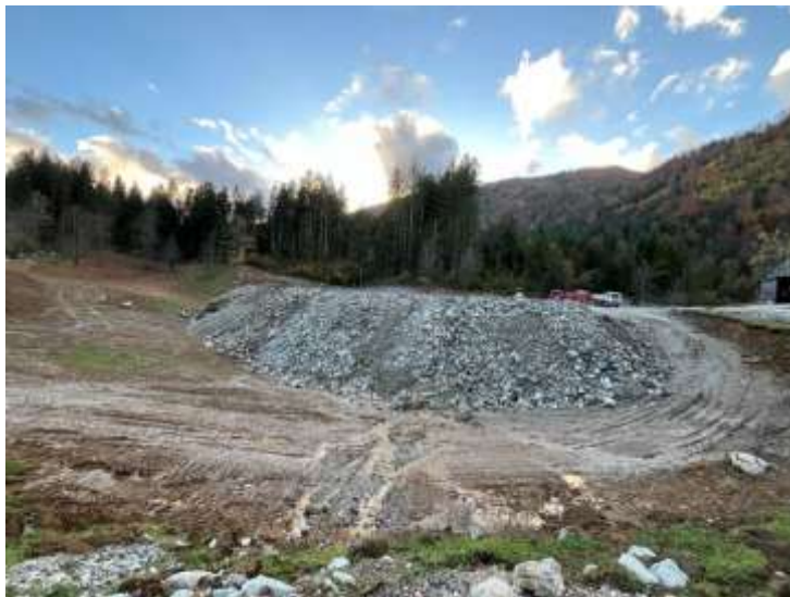
Slika 48: Ostanke porušene hiše 86
