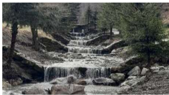
Slika 10: Pregrade za stabilizacijo 20
